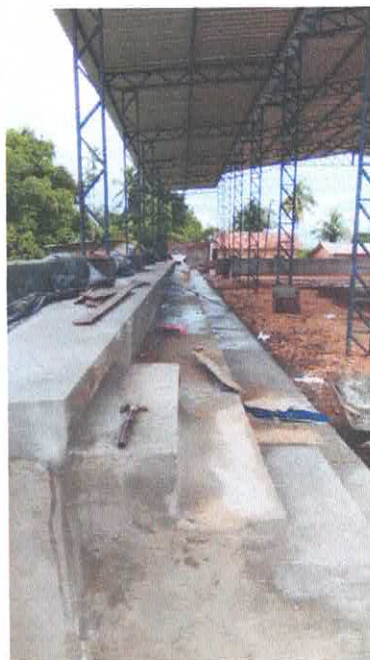
Imagem 07: Construção de quadra poliesportiva.
