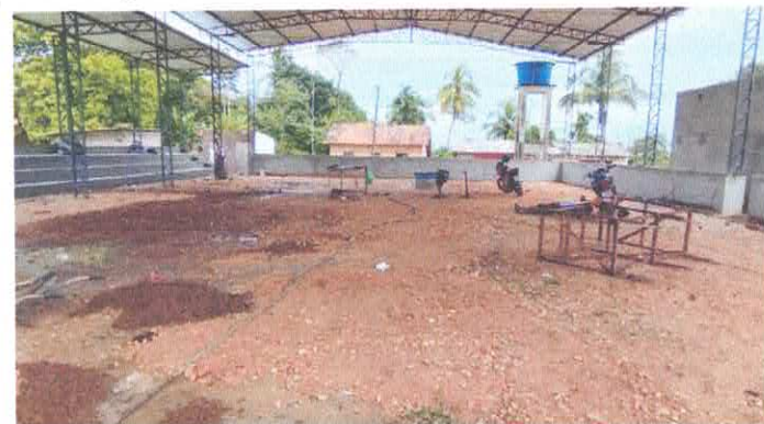
Imagem 06: Construção de quadra poliesportiva
