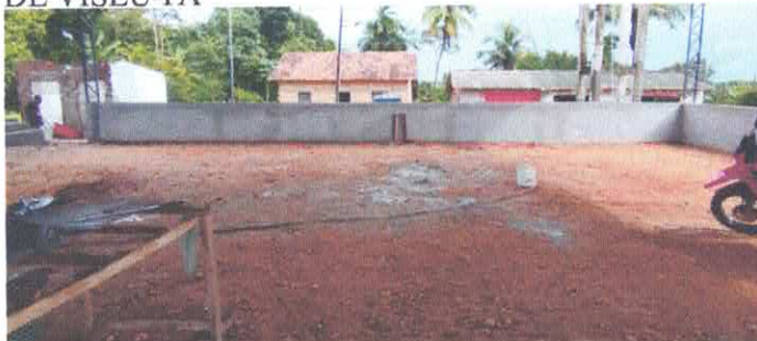
Imagem 01: Construção de quadra poliesportiva.
