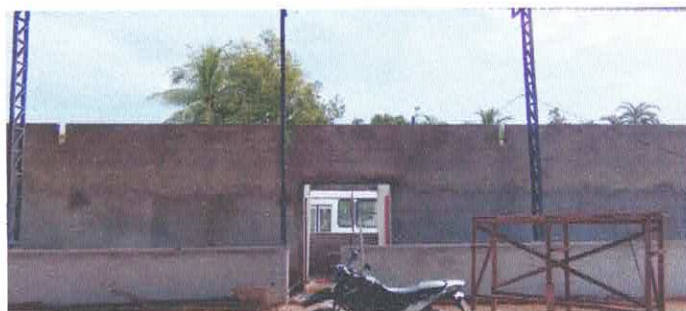
Imagem 05: Construção de quadra poliesportiva.
