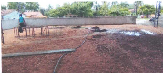
Imagem 02: Construção de quadra poliesportiva.
