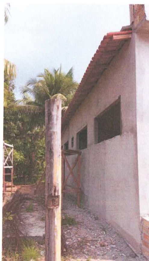
Imagem 03: Construção UBS Carrapatinho
