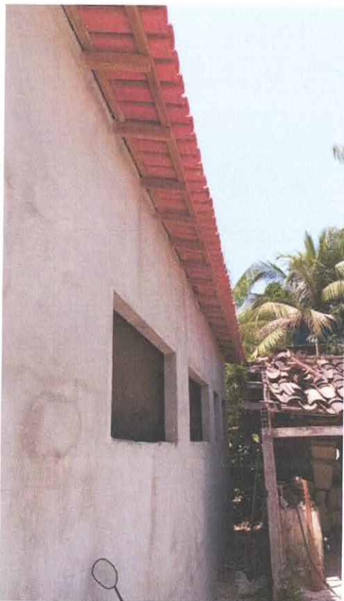
Imagem 02: Construção UBS Carrapatinho
