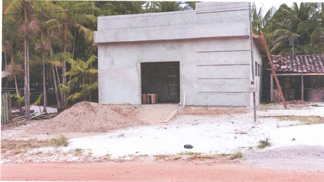
Imagem 01: Construção UBS Carrapatinho
