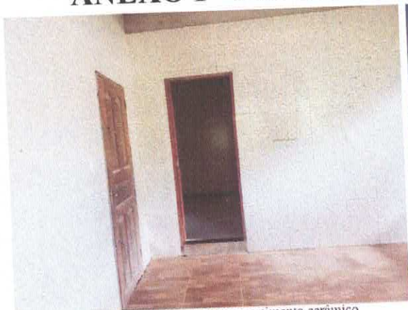
Imagem 01: Ambiente com revestimento cerâmico
